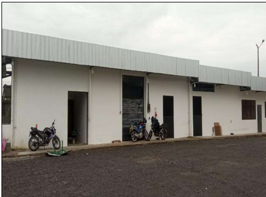
Fotografía No. 11. Taller de mantenimiento de la planta
